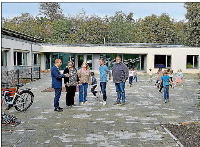
Die Sanierungsarbeiten am Schulhof der Waldschule sind weitestgehend abgeschlossen. Das ergab eine Besichtigung vor Ort.
